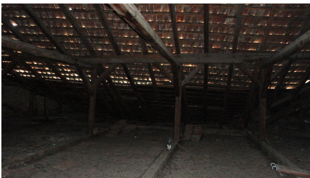
STRUCTURA SARPANTA CU INVELITORI TIGLE PROFILATE
