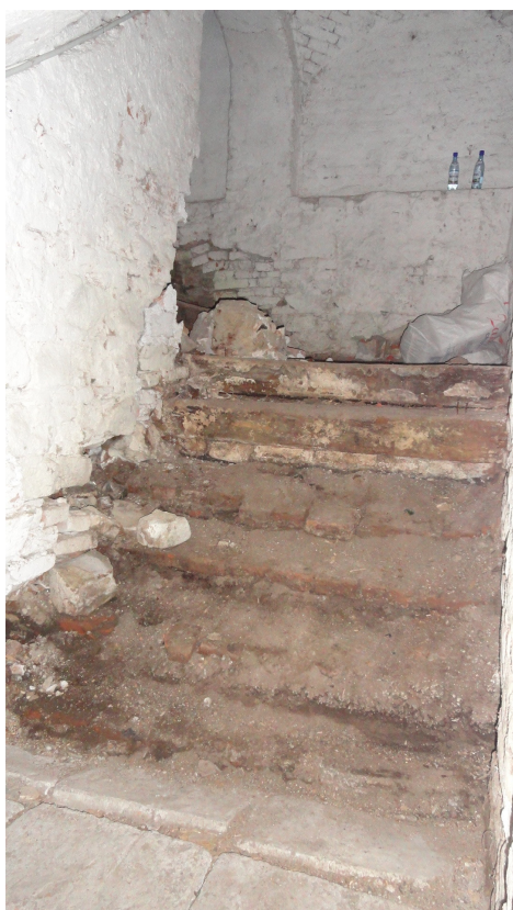
DEGRADAREA BIOLOGICA A TREPTELOR DIN LEMN
