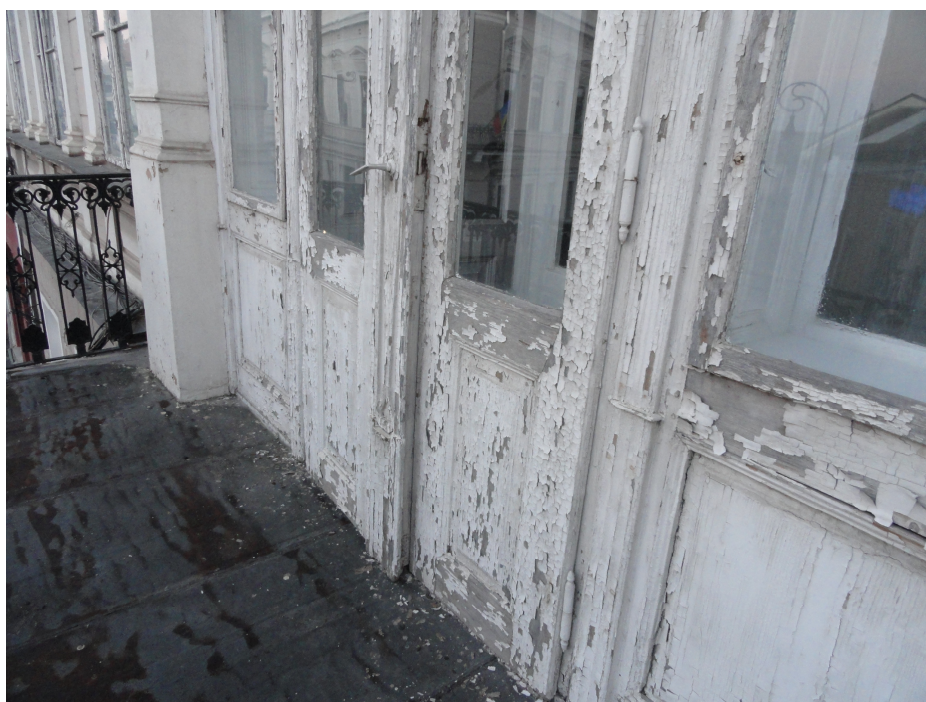
DEGRADAREA TAMPLARIEI DE ACCES PE TERASA – FATADA NORD
